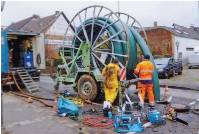
Hier werden die neuen Kunststoffkanalrohre in die alten Betonrohre eingeführt. Am bestehenden Hausanschluss wurde der alte Kanal zerstört und ein Kunststoff-Abwasserrohr an den neuen Kanal angeschlossen.
